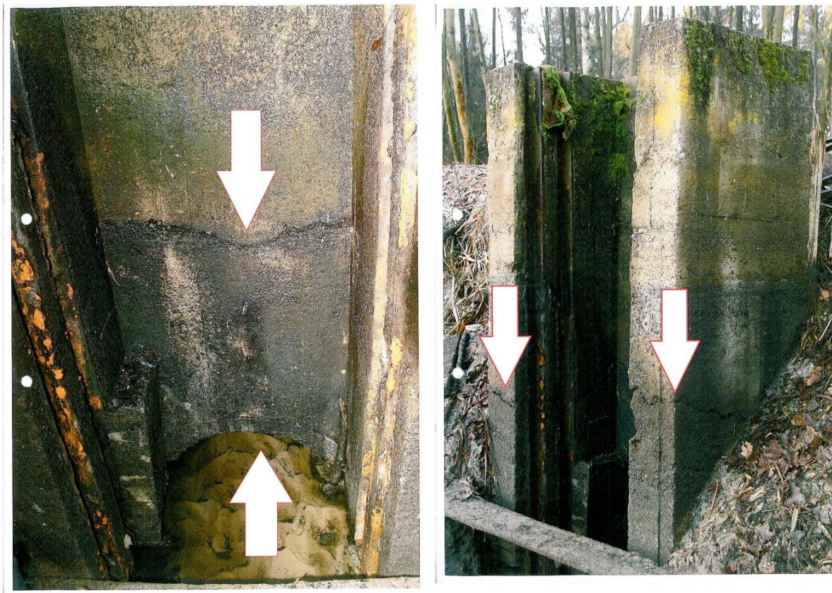
Rysunek 3. Mnich spustowy na rowie SN-5.1. piętrzący wodę w stawie / bud.nr 3/
