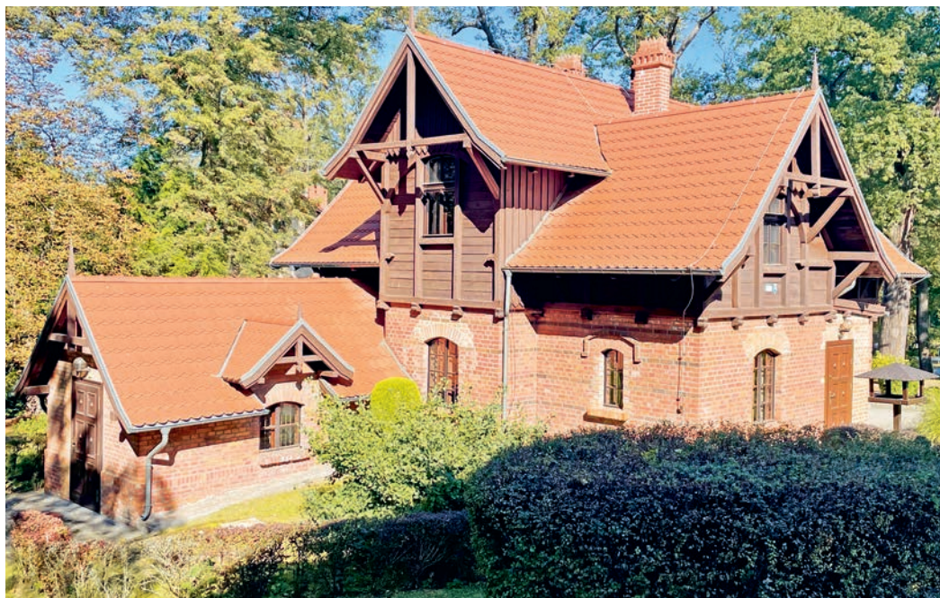
Ryc. 10. Budynek Ogrodówki – widok współczesny, fot. B. Nadolna, 1 października 2024 r.
