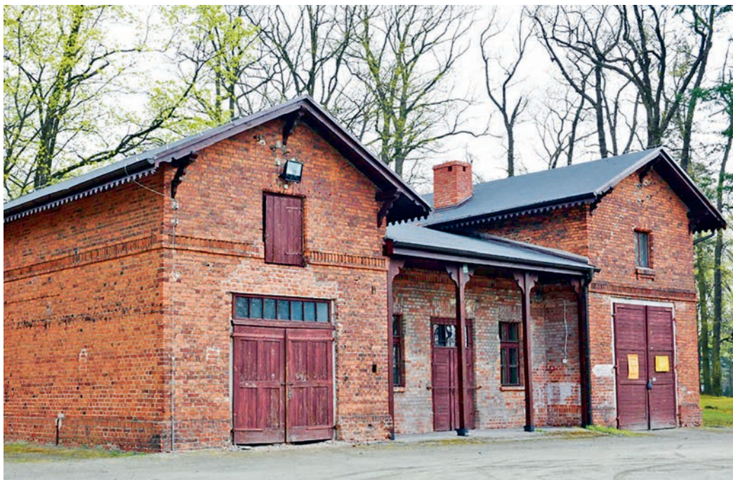
Ryc. 6. Budynek dawnej stajni-wozowni przed remontem, fot. A. Całka, 13 kwietnia 2016 r.
