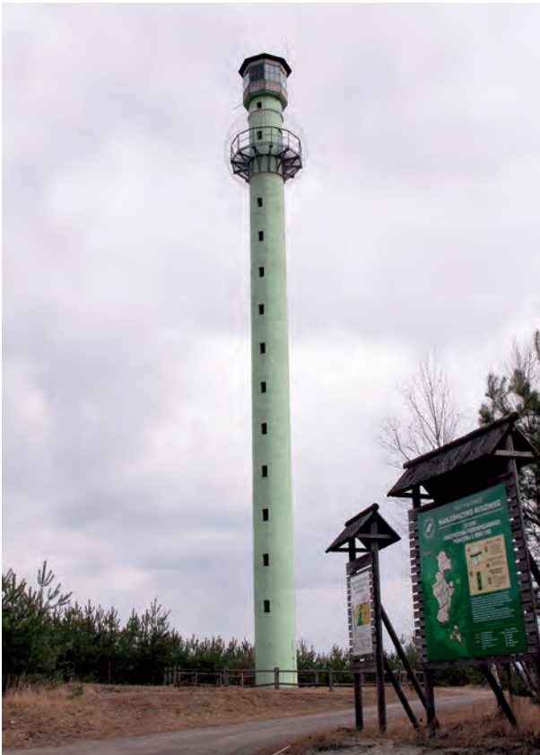
Dostrzegalnia „Łączka” w leśnictwie Sierakowice, Nadleśnictwo Rudziniec. Wieża ma 36 m wysokości, zbudowano ją tzw. metodą ślizgową w 2000 r. w ciągu zaledwie 13 dni (K.F.)
