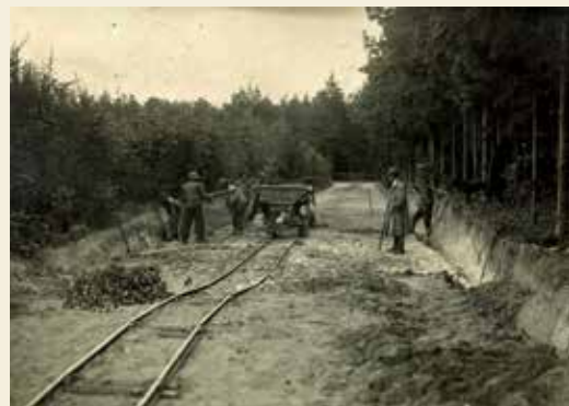
Zdjęcie przedstawia miejsce budowy kolejki wąskotorowej, która łączyła leśnictwo Bytyń, gdzie zlokalizowany był tartak, z miejscowością Kaźmierz (lokalizacja dworca oraz linii PKP). Tory kolejowe nie zachowały się do czasów współczesnych
