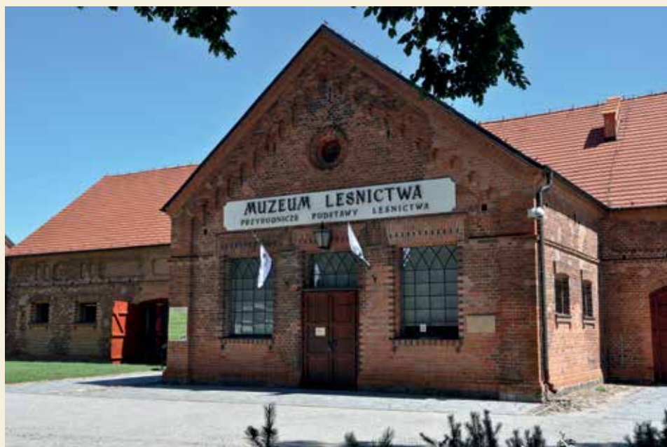
„Powozowania” - budynek wzniesiony w 1854 r.z inicjatywy Jana Działyńskiego. Służył przez lata jako stajnia dla koni cugowych i pod wierzch oraz miejsce garażowania pojazdów. Po generalnym remoncie, przeprowadzonym w końcu ubiegłego stulecia, urządzono w niej stałą wystawę z zakresu przyrodniczych podstaw leśnictwa zatytułowaną „Spotkanie z lasem”
