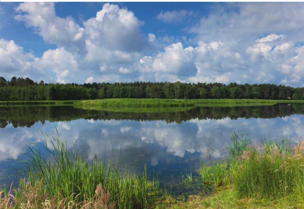
Zbiornik Goszczyn po przebudowie (Klady)
